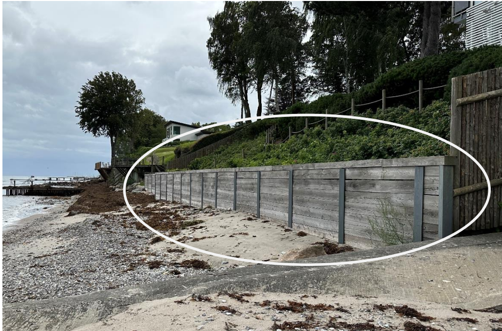
Figur 1 - Københavnermur. Spuns med træ. Samme kyststrækning har denne kystbeskyttelsestype. Billedet er taget i samme strækning.
